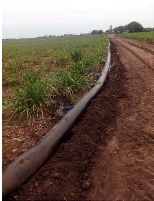
Para ello, la derivación a las parcelas se realiza mediante compuertas con salidas entubadas, generalmente con tubos de PVC de baja presión.
