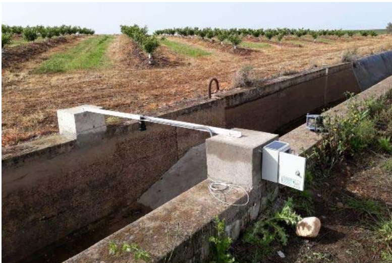
Ilustración 4 Registrador SP-Durcas equipado con sensor Ecosonda, midiendo la carga de Aforador ACA construido en acequia rectangular, para la medición del caudal
