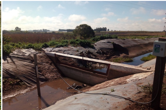
Medición de carga en vertedero trapezoidal Cipolletti
